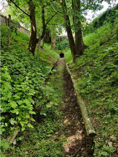
Nördlicher Bereich, Salzmesserstraße
